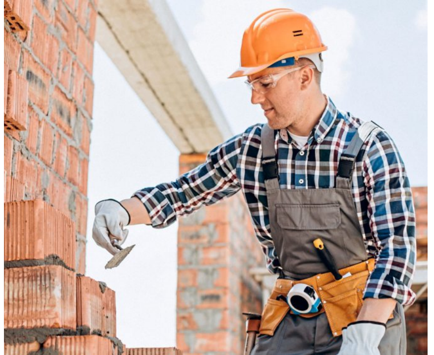
Der Rohbau muss exakt nach Plan gebaut werden.
