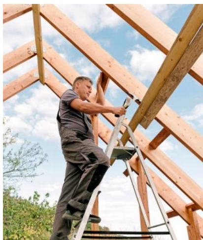
Beim Bau des Daches kommt es auf viele wichtige Details an. Foto: Freepik
