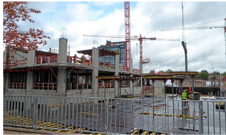
Im Norden des Neubaus werden weitere Büro-Komplexe gebaut.
