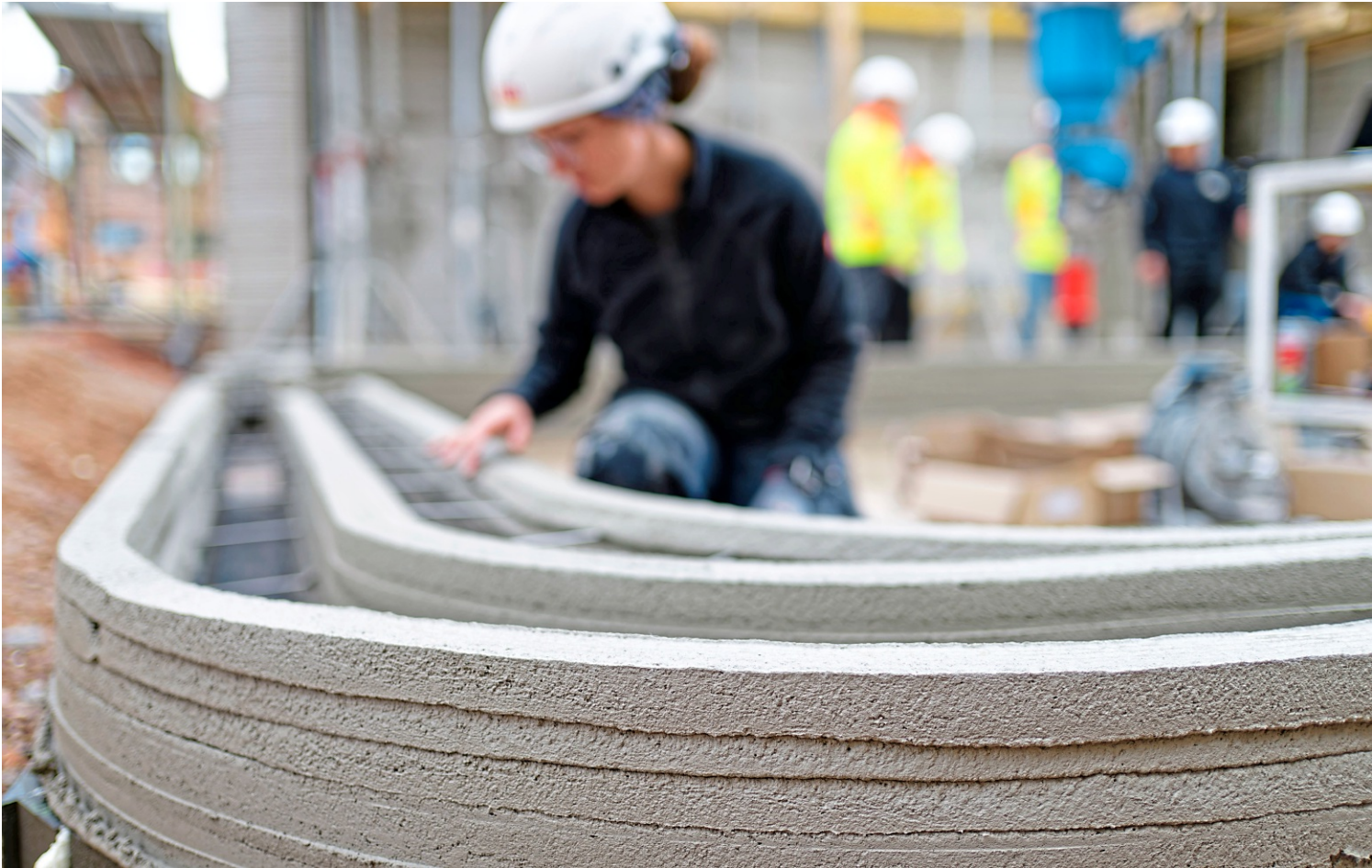
Eine Mitarbeiterin betrachtet übereinandergeschichtete Betonstreifen, die von einem seriellen 3D-Gebäudedruker gesetzt wurden.
